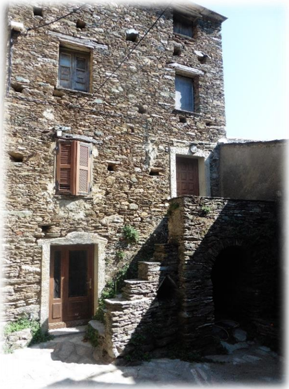
Sommige huizen zijn geheel opgetrokken in de leisteen die ze ter plaatse hebben kunnen vinden. Sommige daken zijn zelfs bedekt met van die dikke leistenen.
