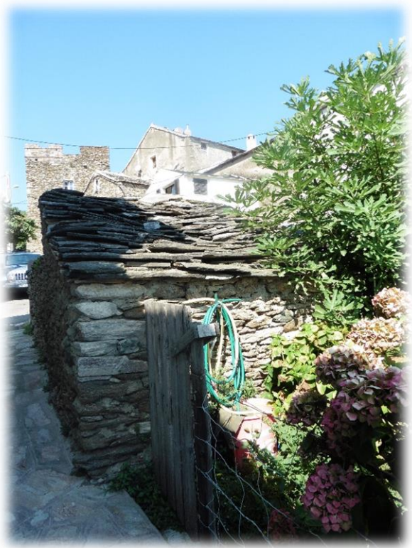
Sommige huizen zijn geheel opgetrokken in de leisteen die ze ter plaatse hebben kunnen vinden. Sommige daken zijn zelfs bedekt met van die dikke leistenen.
